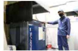
コンプレッサはインバータ付 きに更新済み
