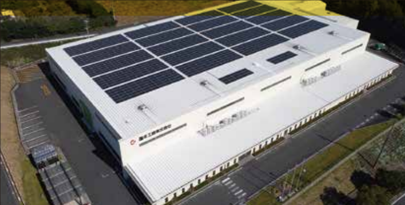
浜北工場の屋根に搭載した太陽光発電により、使用電力の19%を自家発電
