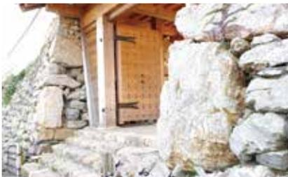
天守門は発掘調査結果や絵図に従って復元。明治時代以降に造られたものを撤去し新たに設置した石段や、柱を礎石の形に合わせて加工する「ひかりつけ」など、細部を見るのも醍醐味
