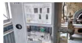
配管の保温が不十分と指摘されたボイラー。今後は保温カバーを用いて補修を行い、放射熱量を減らすことでボイラーの燃料消費量の削減を図る
